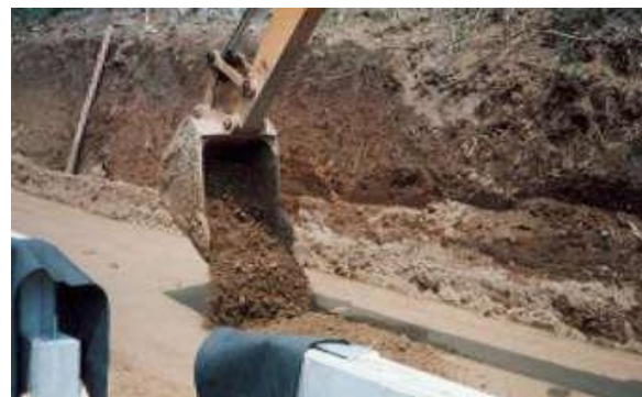
⑤盛土材敷均し
