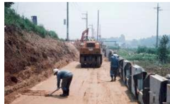
⑥盛土材締固め
